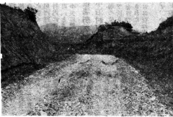
鏡～太田線道路改良工事…昭和36年度、工費2,738千円 (改良延長1,431メートル)
