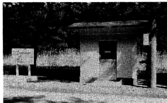
▶完成した二次減圧室
