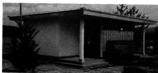
▲中の島公衆便所
