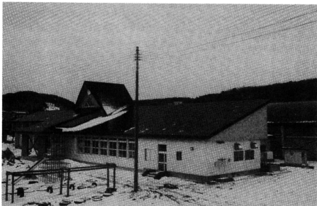
太田小学校校舎増改築 工事費 111,355千円 木造平屋建 645.54㎡
