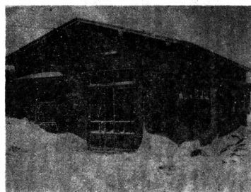
教員住宅建設工事2,230千円 (脇元、十三、太田各一戸)
