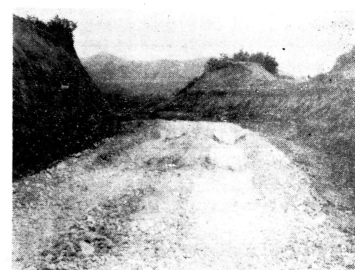
太田道路改良工事5,141千円
