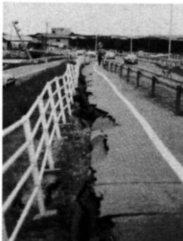
道路が陥没し、アスファルトが波を打つ
