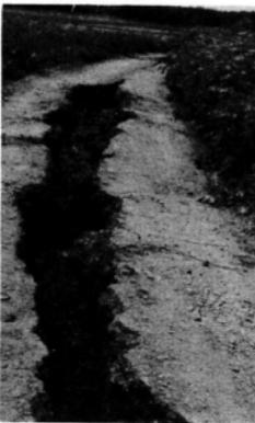
大きく地割れし、陥没した相内川堤防(右)と植え付けたばかりの水田にも地割れが走る(左)
