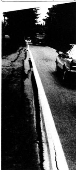
県道にも大きな亀裂が走り地下水の噴出や隆起、陥没が多くみられた。
