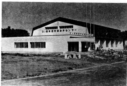
B&G市浦海洋センターの建設工事は急ピッチで進められている
