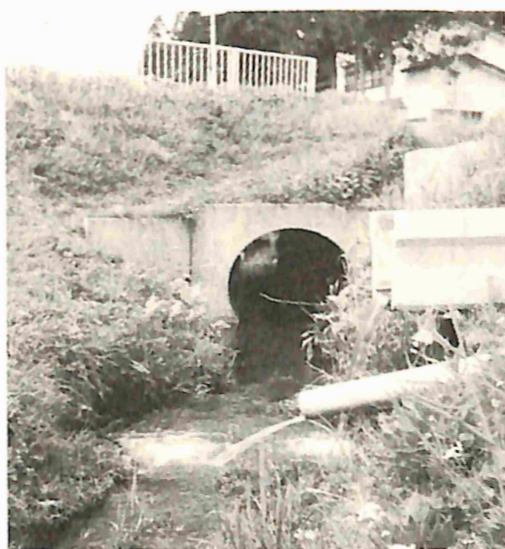
⑤岩見町下喜良市道下をくぐる
