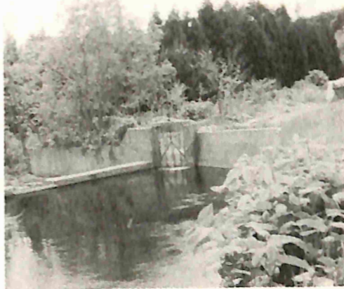
②新水門取入口
