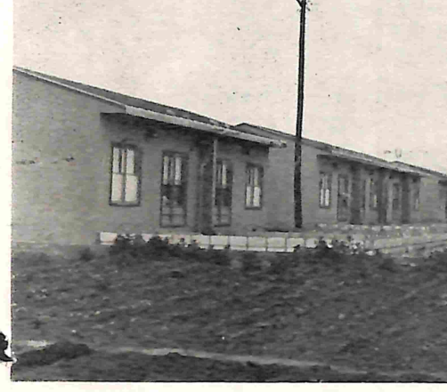
【完成した町営住宅】
