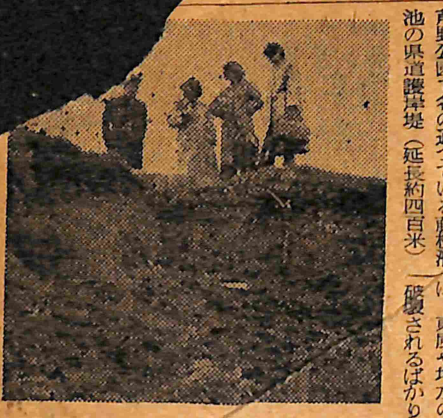
菅野公園で名の通つている護岸堤は、東風や増水のためなどに老朽池の県道護岸堤(延長約四百米) 護岸されるばかりでなく、護岸堤
