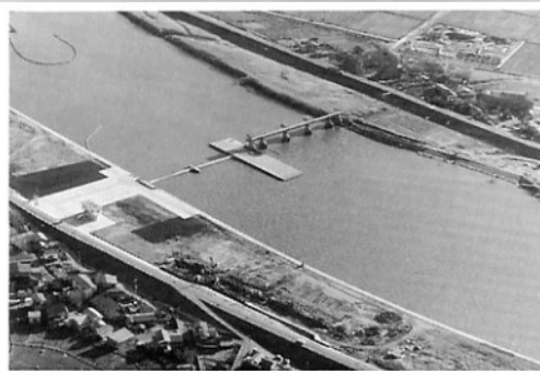
▲岩木川に設置されたゴム堰の全景
