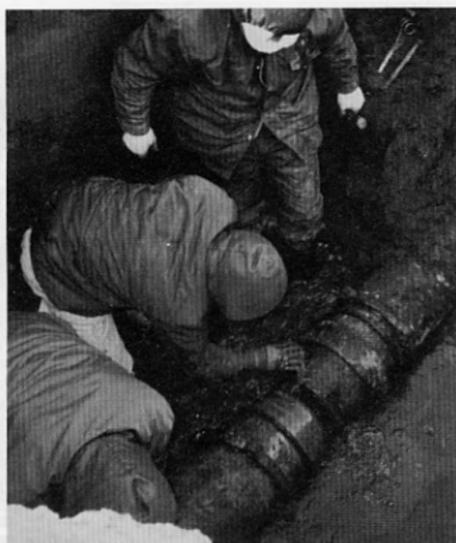
ないような小さな穴からでも高い水圧により周りの砂を巻き込み回転させ管をだんだん削り取って漏水量を多くしていきます。
