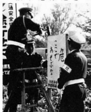
危険箇所を看板を立てる隊員
