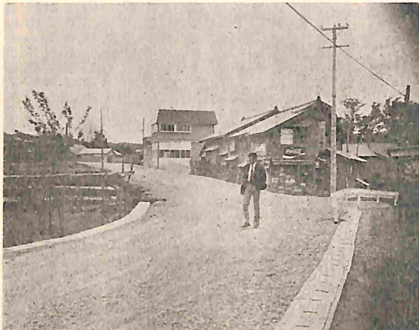
【整備中の柏木線道路】
