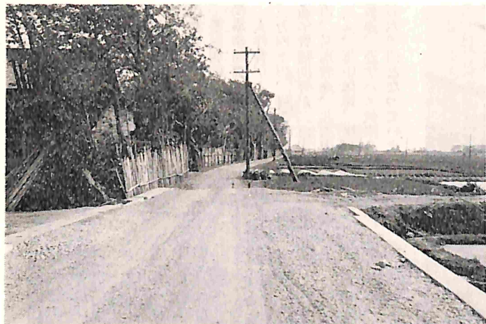
【写真=4年計画で拡巾改良する町道藤枝線】
