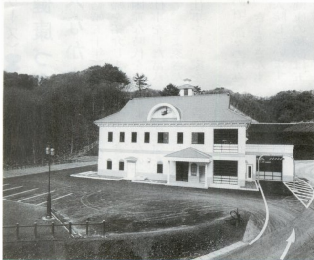
一般廃棄物最終処分場 浸出水処理施設・管理棟
