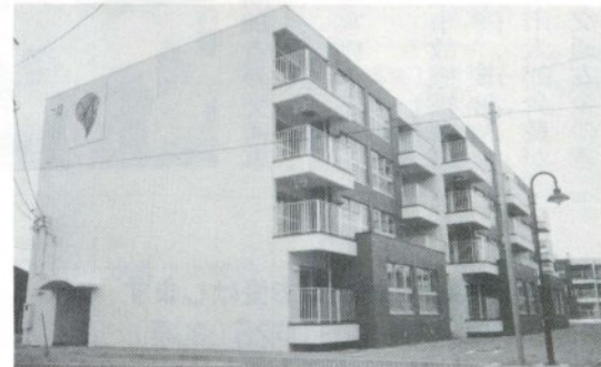
公営住宅(富士見住宅)
