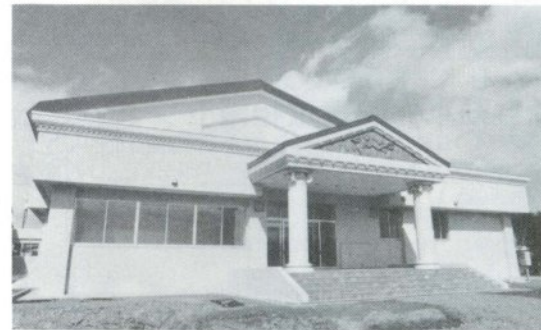
飯詰小学校屋内体育館
