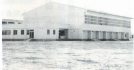
長橋小学校屋内運動場
