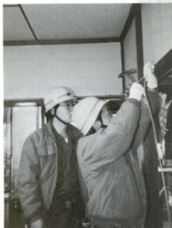
コンセント取り付け工事も手際よく
