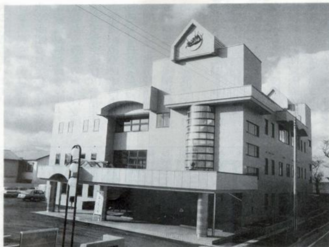
完成した水道事業所中央管理センター
