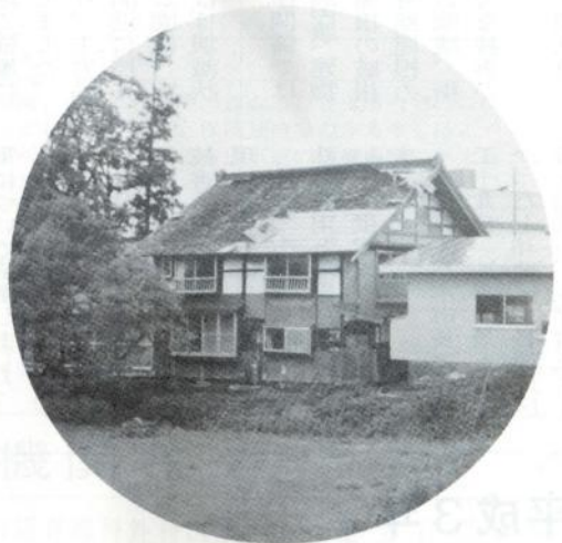
屋根のトタンが吹き飛ばされた住宅
