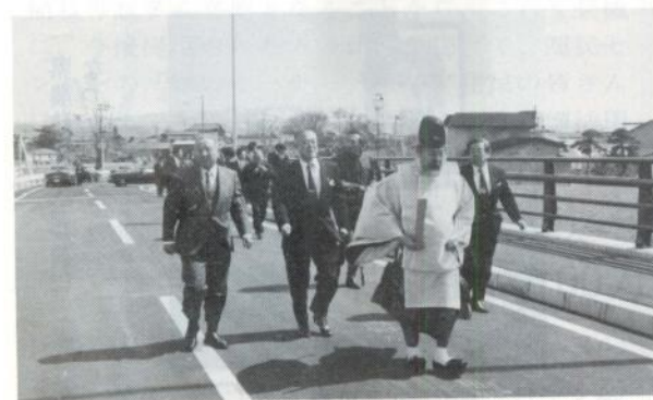
関係者による下中泊橋の渡り初め
