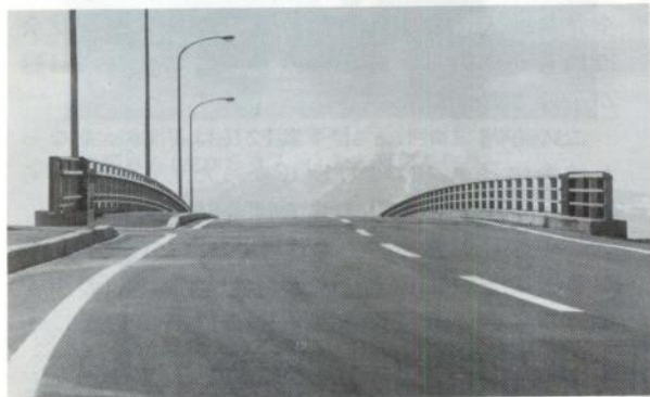
完成した上中泊橋
