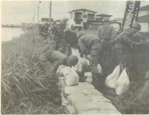
自衛隊員による一ツ谷地区の旧十川堤防で行われた土のう積み作業
