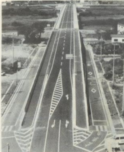
8月30日開通した五所川原大橋
