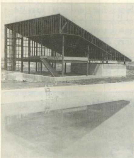
着々と工事が進む市民プール
