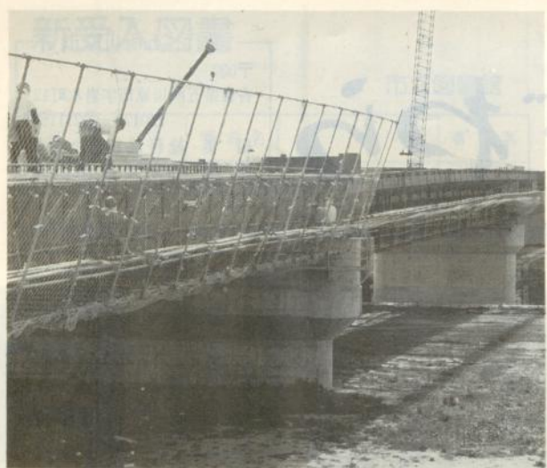
五所川原大橋の建設現場
