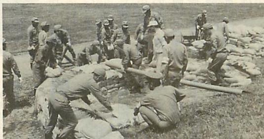
岩木川水系及び馬淵川水系合同水防訓練を実施(6.25)。写真は「月の輪工法」の土のう積みをする水防団員達
