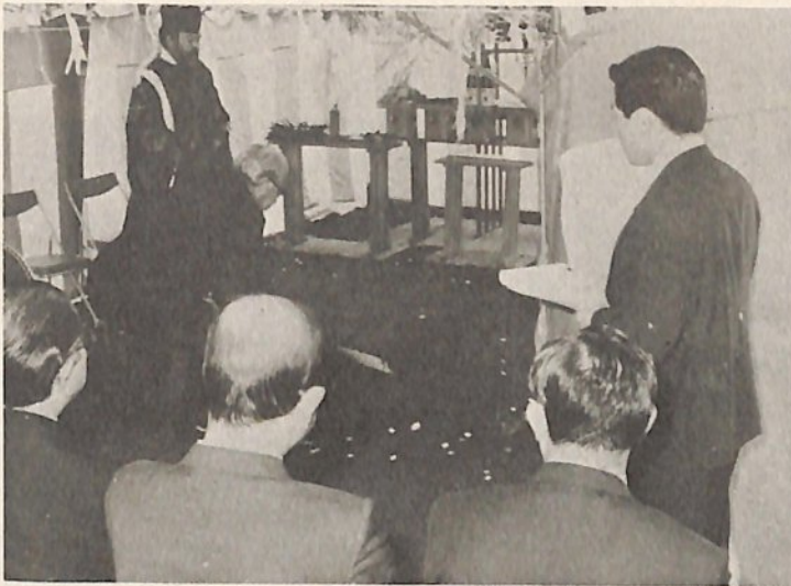
「新津軽大橋」建設 地鎮祭
