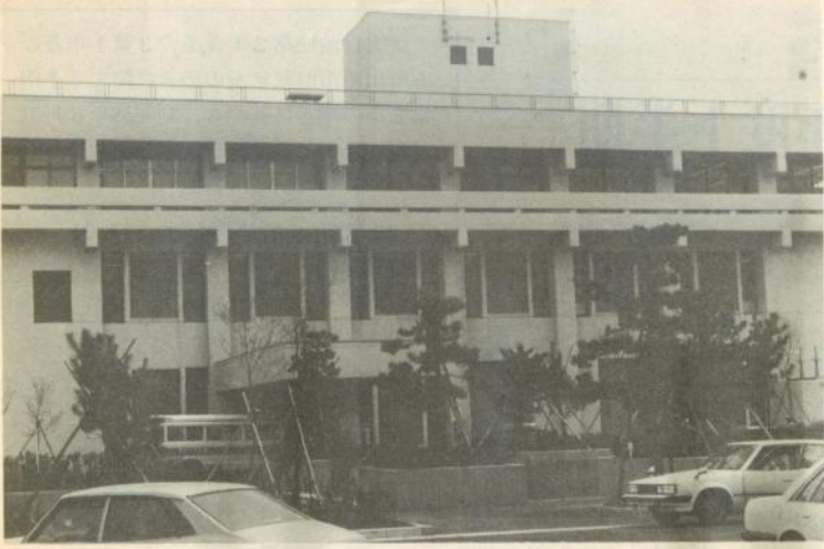
完成した浄化センターの全景
