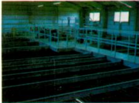
▲第4次上水道拡張事業
