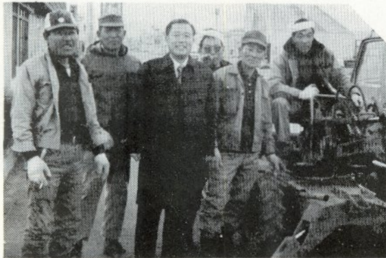
立川バイパス街路樹道道路工事にて
