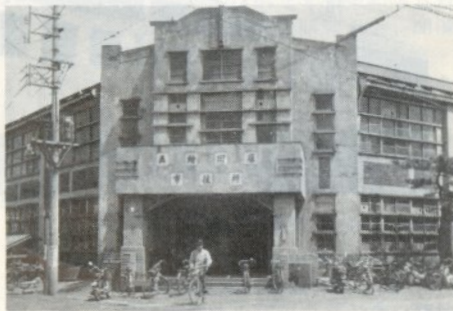
旭町にあった旧市庁舎（現五所川原郵便局舎建設現場）
