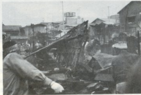
焼け跡の復旧作業
