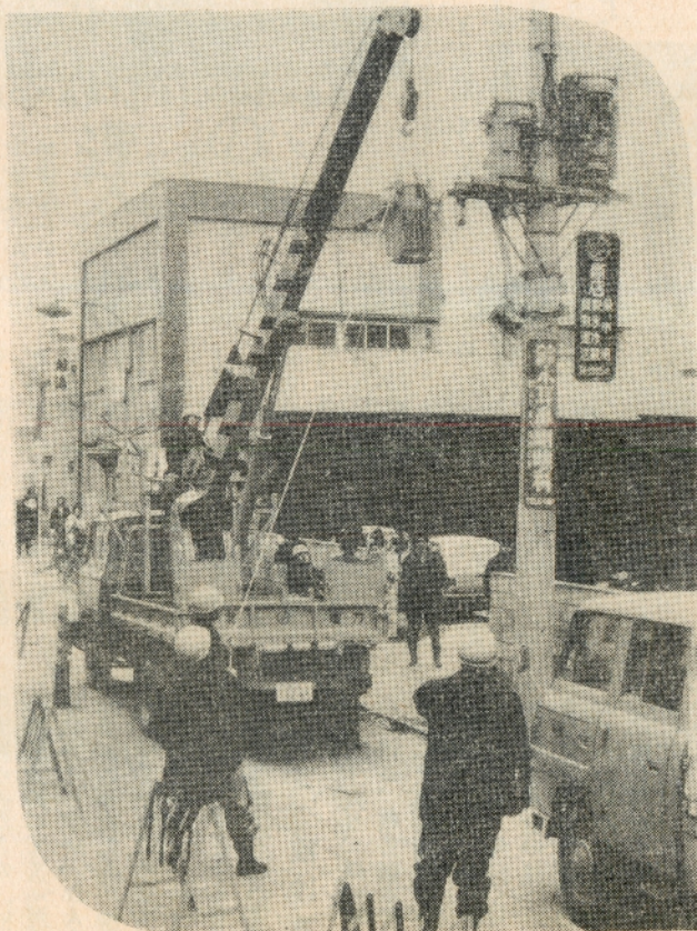
東北電力による電力復旧訓練
