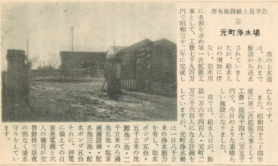
市の上水道は、それまで飯詰から送水されていましたが、給水人口の増加に伴い、岩木川市では、給水人口が、飯詰一万六千四百人・元町二万三千六百になる計画を立てていますが、元町浄水場は一日八千立米の浄水能力を有し、取水ポンプ五台・五千立米の沈澱池二池・二千立米のろ過池五池・塩素滅菌設備・配水池三池・配水ポンプ五台それに、停電に備えての自家発電機と六人の職員が交替勤務で昼夜の別なく清水守りをしていきます。
