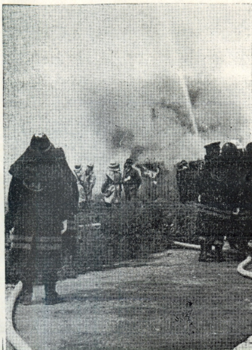
← 第三消防隊の果敢な消火作業
