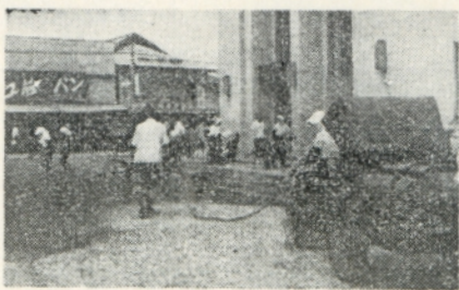
(写真：本町舗装工事)
