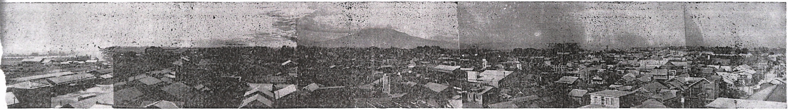
消防署望楼からみおろした市街鳥かん図。駅から南方面
