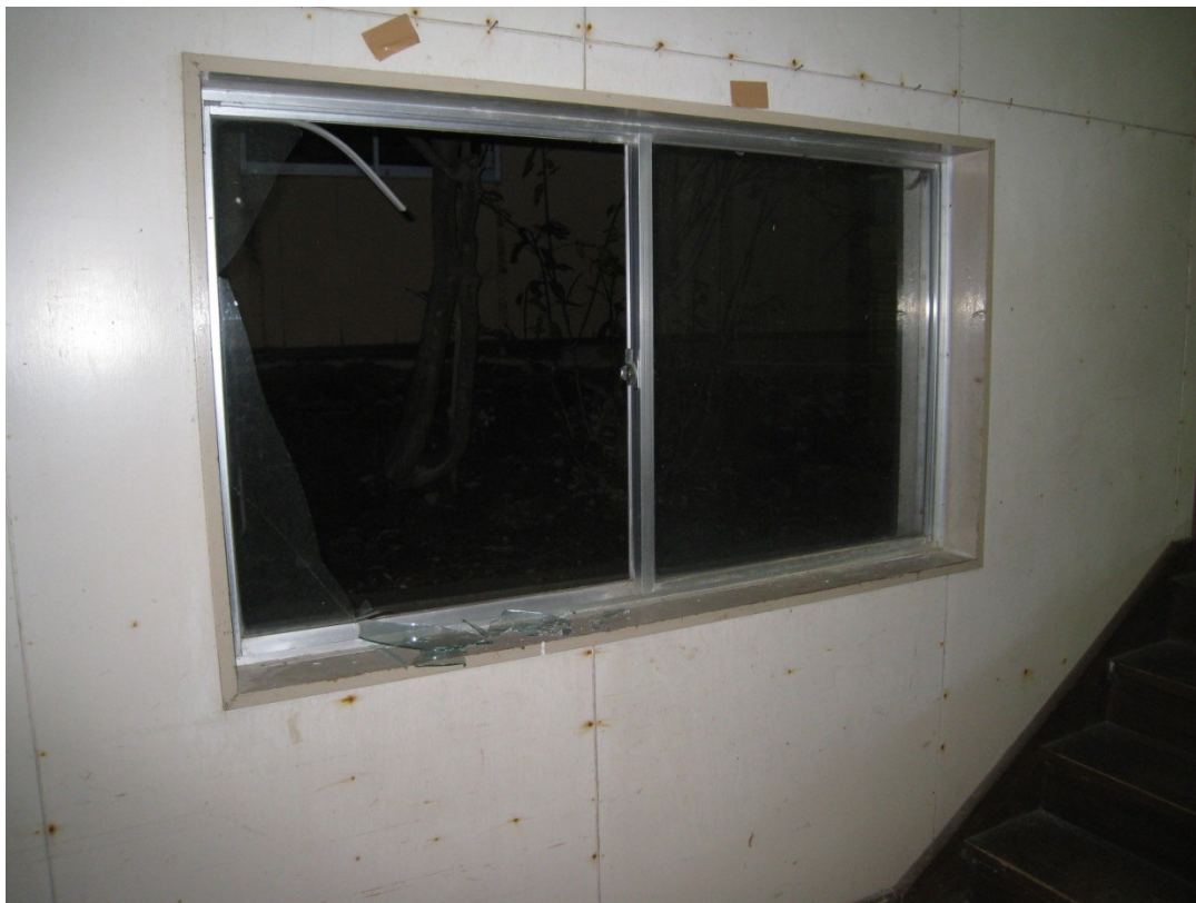
被害箇所 窓ガラス
