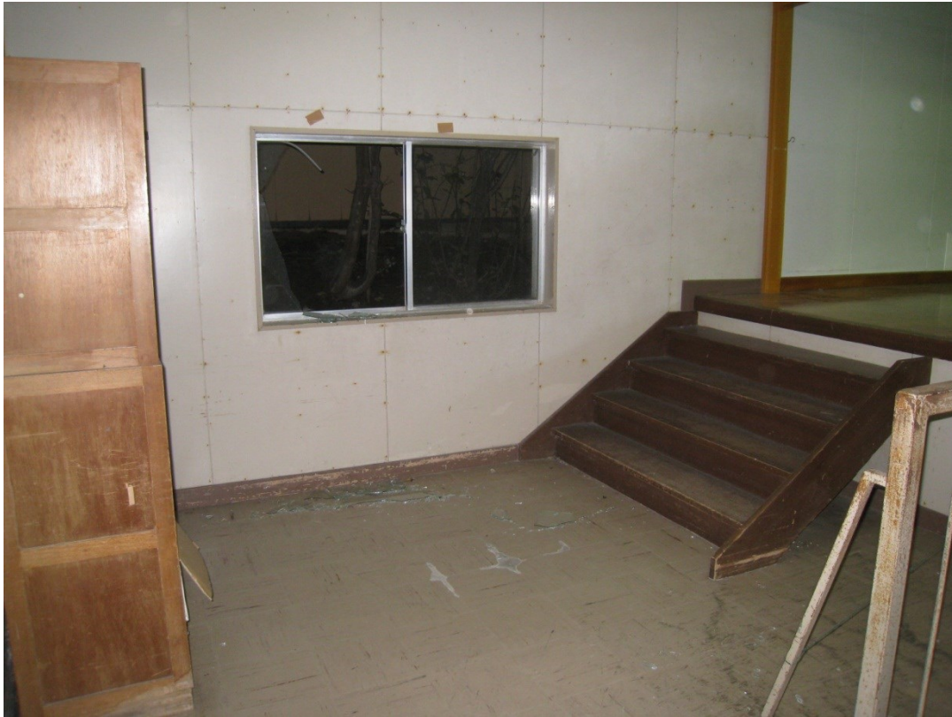
被害箇所 ステージ脇 控室全景
