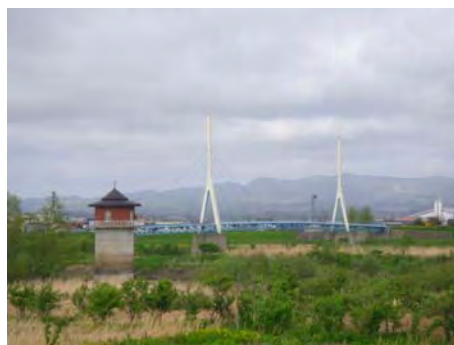
岩木川にある取水塔
