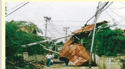
屋根トタン飛散による電柱倒壊(平川市)
