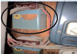
低圧進相コンデンサーの設置例
