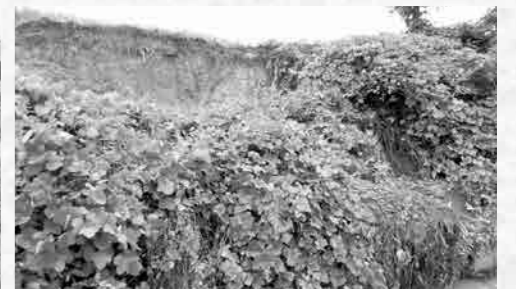
《のり面が崩壊した金木地区の水田》
