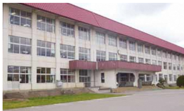
大規模改造される金木小学校校舎
