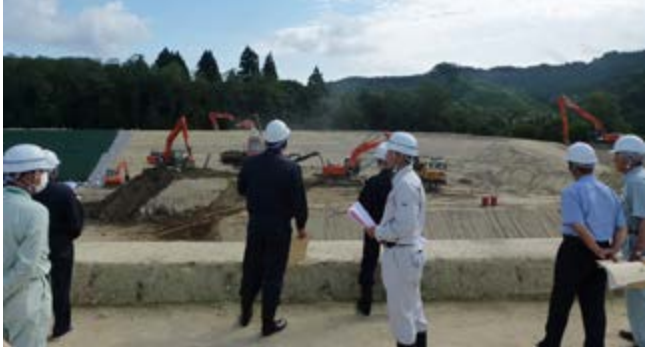
新金木一般廃棄物処分場視察の様子
