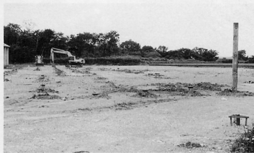
新校舎建設現場
