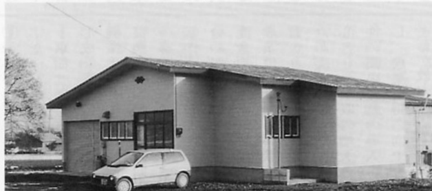
神原地区に完成した「神原防災コミュニティセンター」
