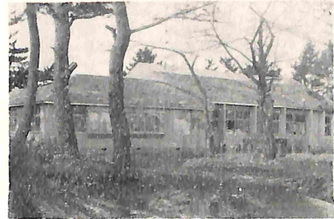
【移転改築された青年研修所】
