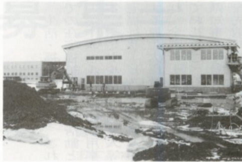
急ピッチで進められている鳥羽工産(株)の工事現場
