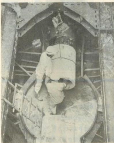
推進工法による下水道本管工事現場
