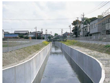
(下水道整備後)
