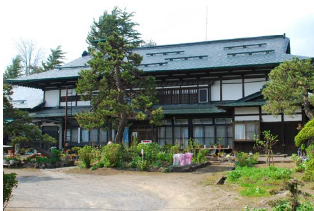
△主屋 木造2階建、銅板葺、 建築面積681㎡
