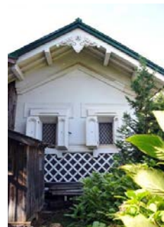
文庫蔵▷ 木造2階建、鉄板葺、 建築面積60㎡
